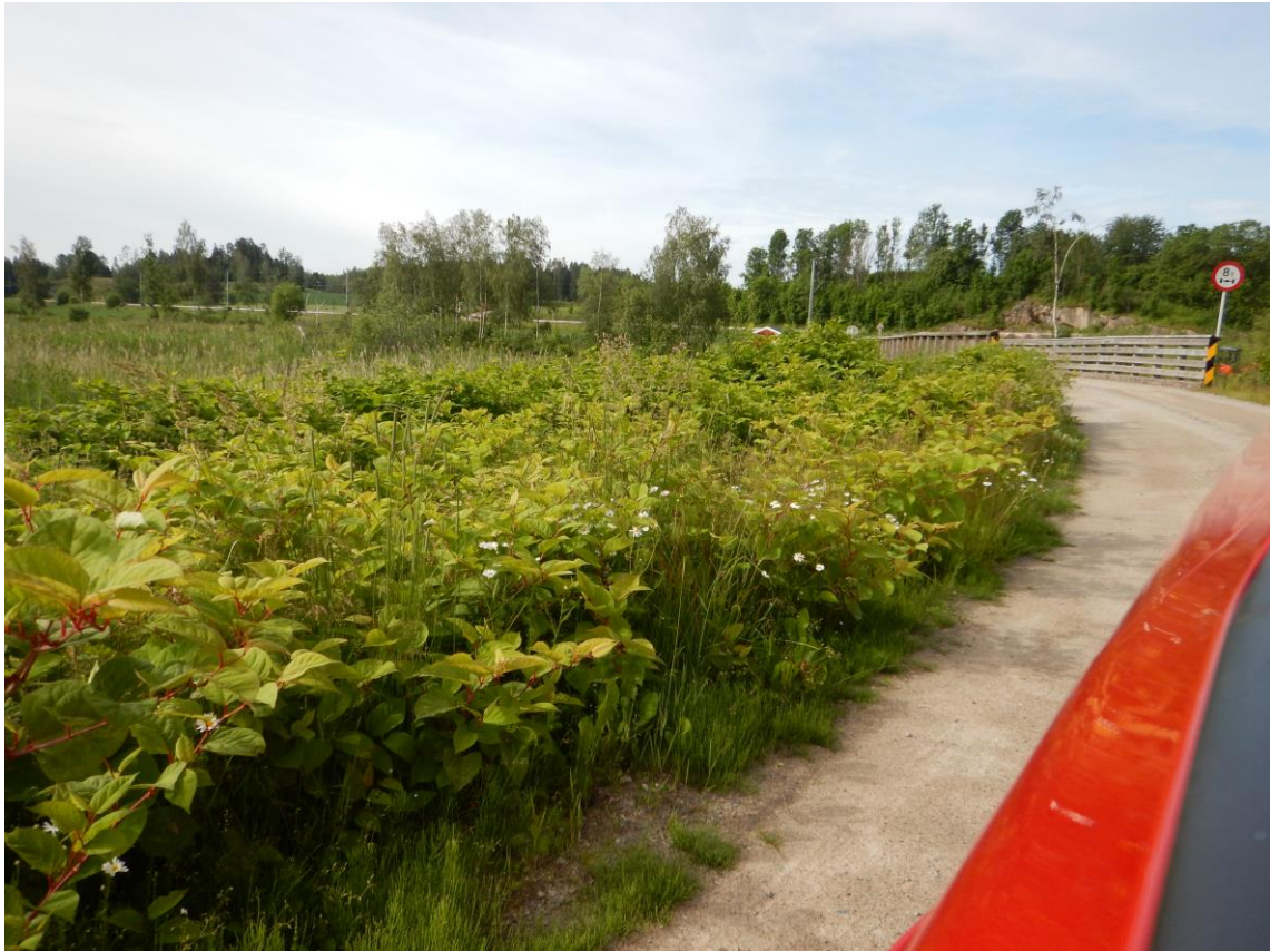
Stor forekomst av den aggressive fremmedarten parkslirekne ble påvist på begge sider av Høyumbrua over Seutelva (Lokalitet 13 av de uprioriterte veistrekningene, se vedlegg 2). Foto: Ola M. Wergeland Krog
