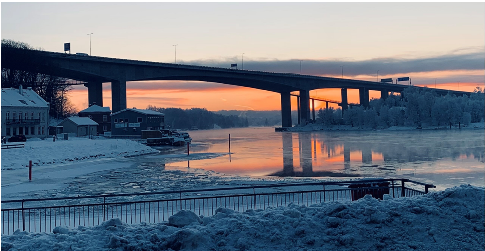
Figur 5: Sandesund bru, foto: Sarpsborg kommune
