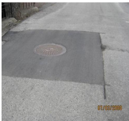
Eksempler på feil og riktig utførelse av skjæring av asfalt rundt kummer.
