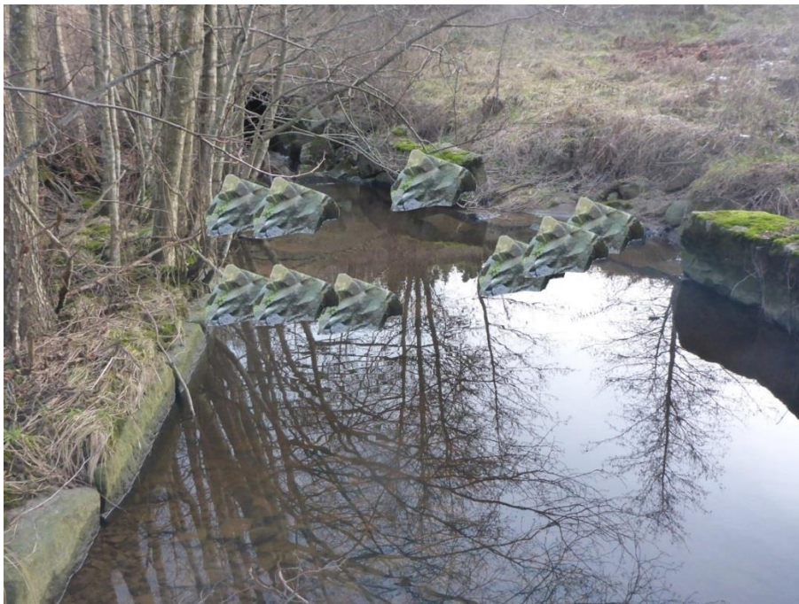
Figur 15. I tillegg til fjerning av stein som blokkerer bekkeløpet umiddelbart nedstrøms kulvert foreslås terskling av kulp som vist på figuren for å heve vannspeilet noe mot utløp av kulvert.
