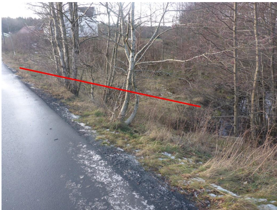
Figur 17. Graver kan enkelt belte seg ned fra veien til kulpen nedstrøms kulvert for utbedring av fiskevandring.
